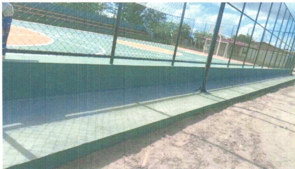
FOTO 17 – APLICAÇÃO DE PISO CIMENTADO, TRAÇO 1:3 (CIMENTO E AREIA), ACABAMENTO LISO, ESPESSURA 4,0 CM, PREPARO MECÂNICO DA ARGAMASSA. AF_09/2020
