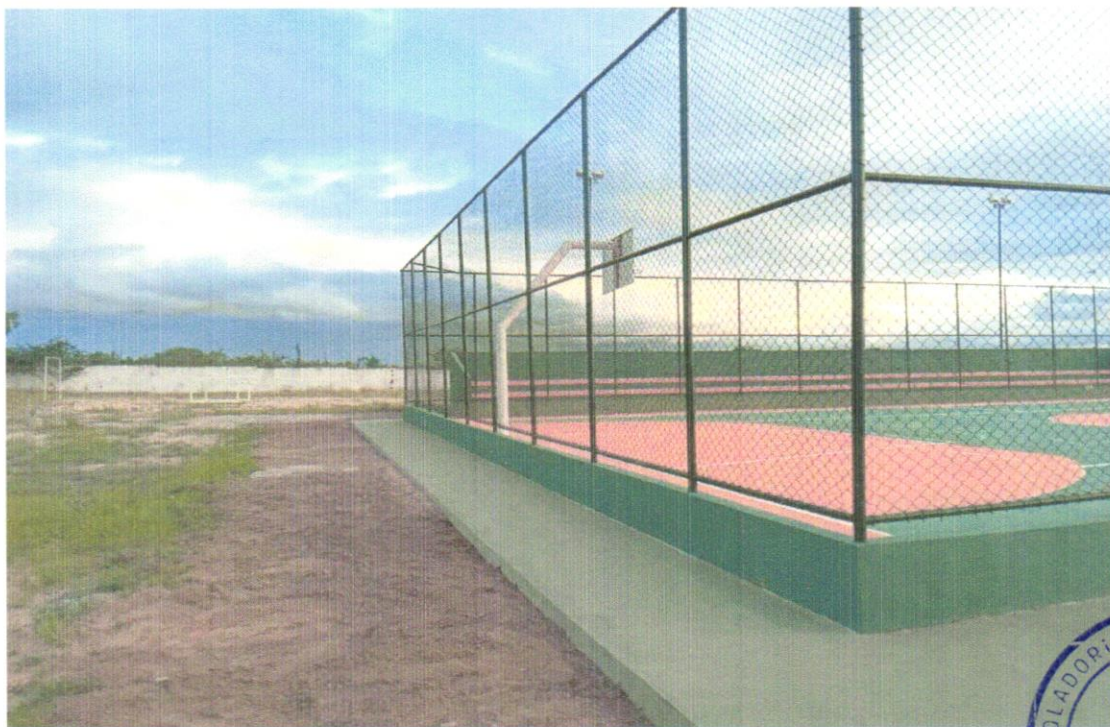
FOTO 14 – APLICAÇÃO DE PISO CIMENTADO, TRAÇO 1:3 (CIMENTO E AREIA), ACABAMENTO LISO, ESPESSURA 4,0 CM, PREPARO MECÂNICO DA ARGAMASSA. AF_09/2020
