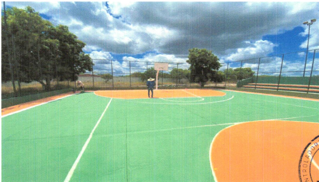
FOTO 12 – PINTURA DE ACABAMENTO COM APLICAÇÃO DE 02 DEMÃOS DE TINTA PVA LÁTEX PARA INTERIORES/EXTERIORES – CORES ESPECIAIS MISTURADAS EM MÁQUINA, TONS CLAROS (MARFIM,PÉROLA,ETC) – REV 01 – (COR BRANCA)
