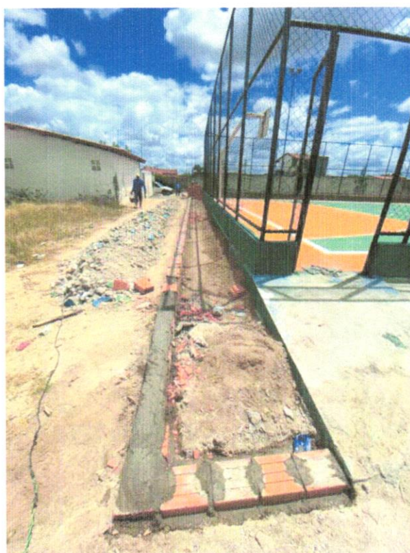
FOTO 02 – ALVENARIA DE VEDAÇÃO DE BLOCOS CERÂMICOS FURADOS NA VERTICAL DE 9X19X39 CM (ESPESSURA 9 CM) E ARGAMASSA DE ASSENTAMENTO COM PREPARO MANUAL. AF_12/2021.
