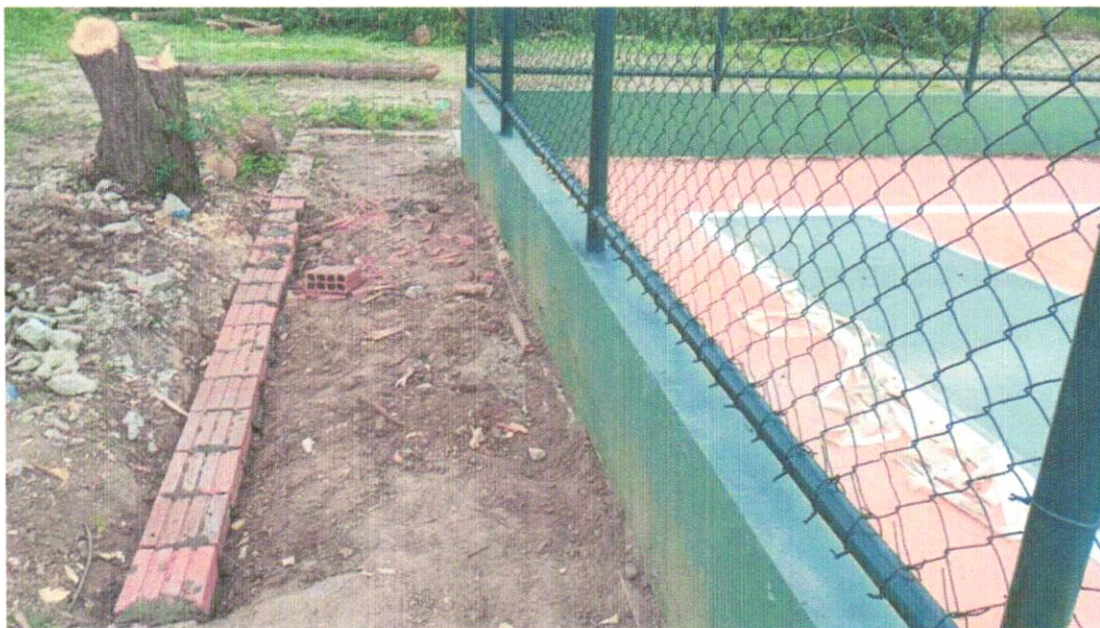
FOTO 03 – ALVENARIA DE VEDAÇÃO DE BLOCOS CERÂMICOS FURADOS NA VERTICAL DE 9X19X39 CM (ESPESSURA 9 CM) E ARGAMASSA DE ASSENTAMENTO COM PREPARO MANUAL. AF_12/2021.
