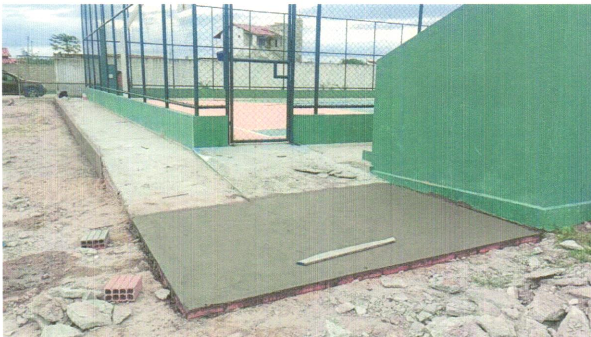
FOTO 19 – APLICAÇÃO DE PISO CIMENTADO, TRAÇO 1:3 (CIMENTO E AREIA), ACABAMENTO LISO, ESPESSURA 4,0 CM, PREPARO MECÂNICO DA ARGAMASSA. AF_09/2020
