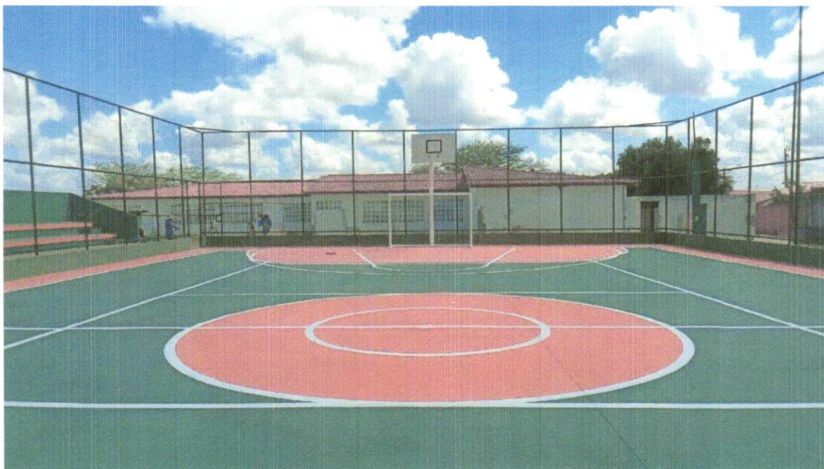
FOTO 09 – PINTURA DE ACABAMENTO COM APLICAÇÃO DE 02 DEMÃOS DE TINTA PVA LÁTEX PARA INTERIORES/EXTERIORES – CORES ESPECIAIS MISTURADAS EM MÁQUINA, TONS CLAROS (MARFIM,PÉROLA,ETC) – REV 01 – (COR VERDE)
