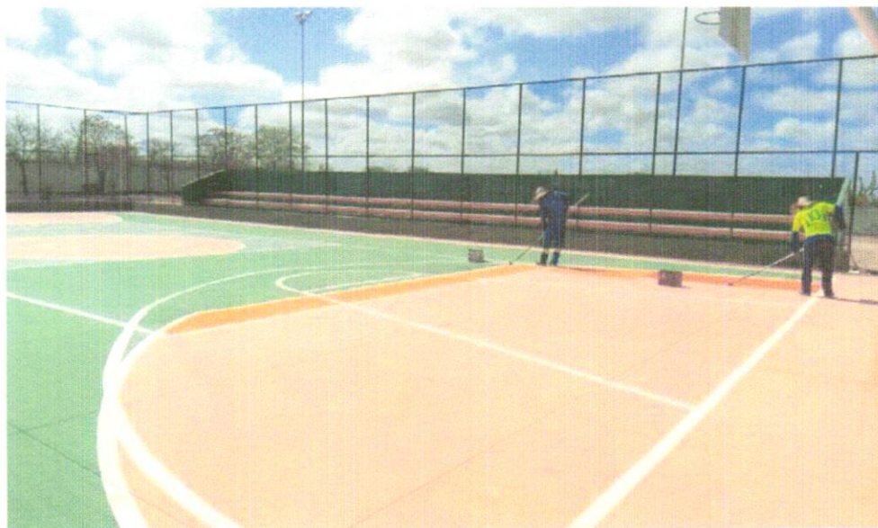
FOTO 01 – INSTALAÇÃO DE TELA DE PROTEÇÃO DE NYLON (3,6MM), MALHA 10X10CM
