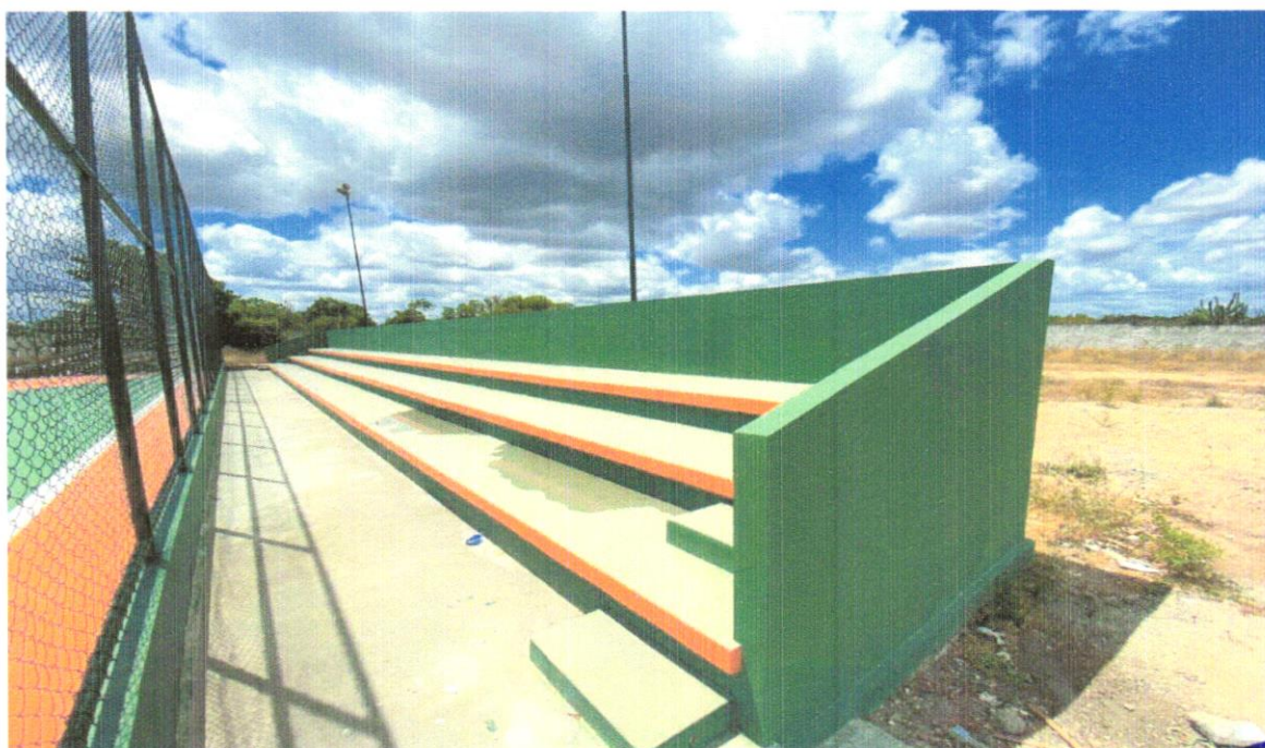
FOTO 20 – APLICAÇÃO DE PISO CIMENTADO, TRAÇO 1:3 (CIMENTO E AREIA), ACABAMENTO LISO, ESPESSURA 2,0 CM, PREPARO MECÂNICO DA ARGAMASSA. AF_09/2020
