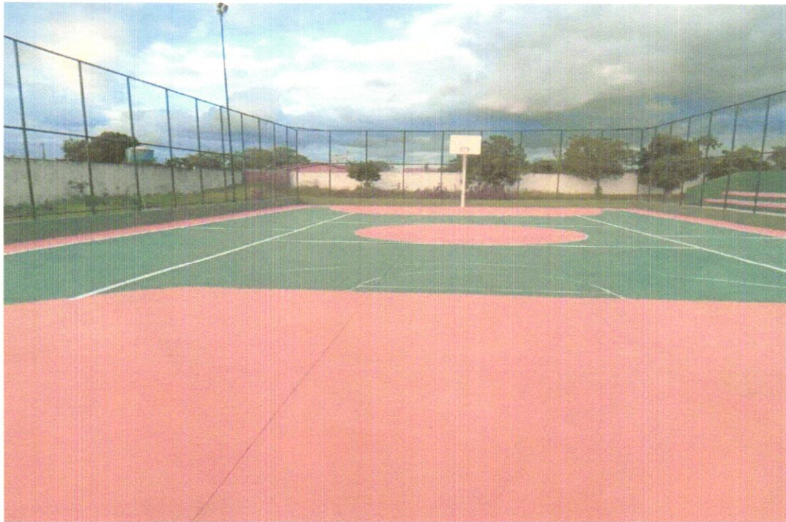
FOTO 11 – PINTURA DE ACABAMENTO COM APLICAÇÃO DE 02 DEMÃOS DE TINTA PVA LÁTEX PARA INTERIORES/EXTERIORES – CORES ESPECIAIS MISTURADAS EM MÁQUINA, TONS CLAROS (MARFIM,PÉROLA,ETC) – REV 01 – (COR LARANJA)
