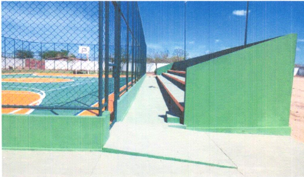
FOTO 23 – APLICAÇÃO MANUAL DE PINTURA COM TINTA LÁTEX ACRÍLICA EM PAREDES, DUAS DEMÃOS. AF_06/2014
