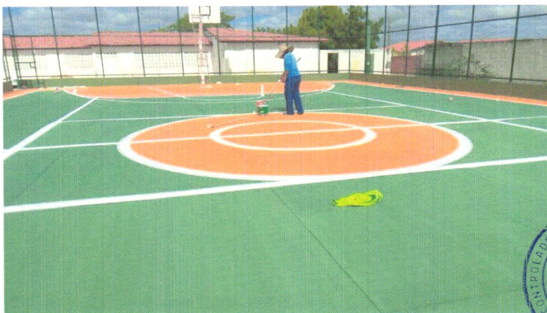
FOTO 08 - PINTURA DE ACABAMENTO COM APLICAÇÃO DE 02 DEMÃOS DE TINTA PVA LATEX PARA INTERIORES/EXTERIORES - CORES ESPECIAIS MISTURADAS EM MÁQUINA, TONS CLAROS (MARFIM, PÉROLA, ETC) - REV 01 - (COR VERDE).
