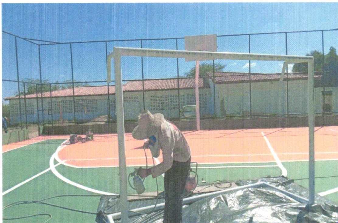
FOTO 06 - PINTURA ESMALTE EM ESTRUTURA METÁLICA, DUAS (2) DEMÃOS, INCLUSIVE, UMA DEMÃO DE FUNDO ANTICORROSIVO.
